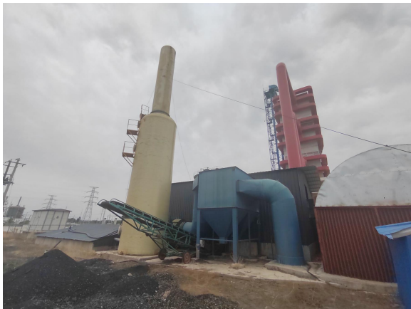
石灰-石膏脱硫塔及布袋除尘器
