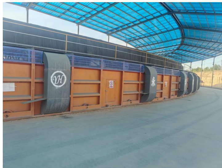
项目区隧道窑
