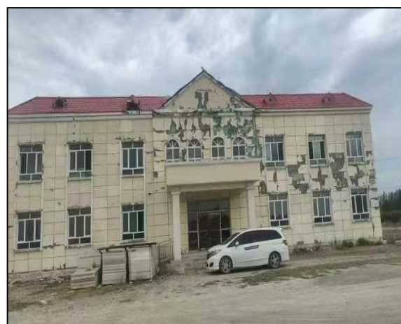
项目区办公楼
